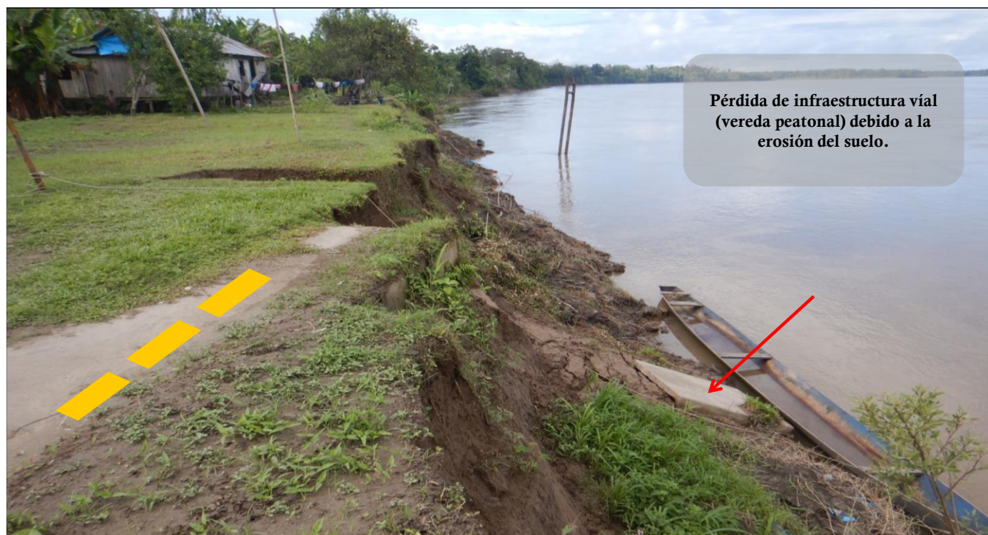
FIGURA N°02: AFECTACIÓN DE VEREDA PEATONAL POR EROSIÓN FLUVIAL
